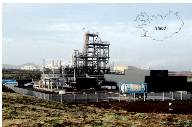
Abbildung 1. Die „George Olah Carbon Dioxide to Renewable Methanol Plant“ von Carbon Recycling International in Island, die die lokale geothermische Energie nutzt. Sie ist die erste kommerzielle Anlage zum Recycling von Kohlendioxid in der Welt (ich danke K. C. Tran, CEO, Carbon Recycling International, Island).
